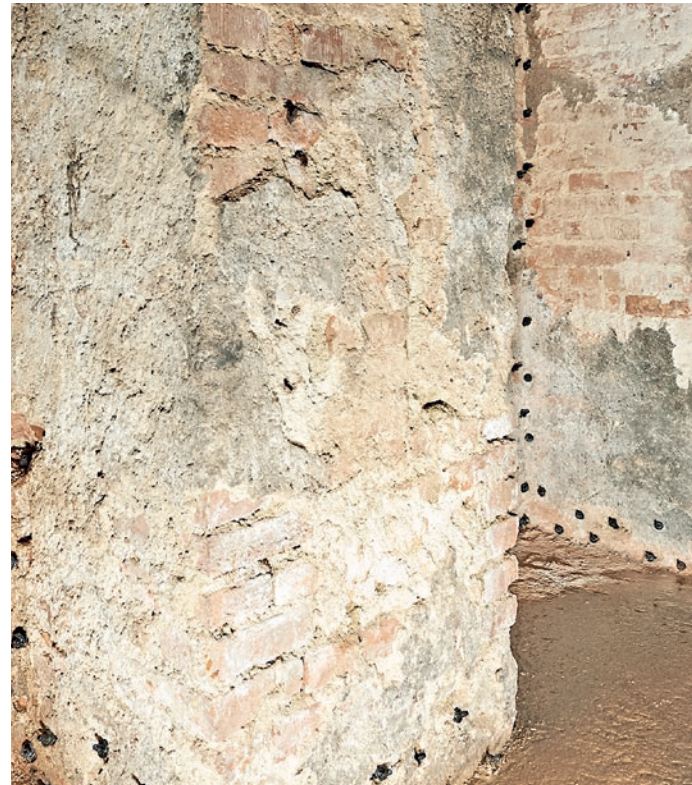
■ Injizieren der Lamellenschlagpacker
