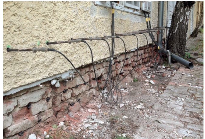
■ Heizstabtrocknung nach erfolgter Horizontalinjektion
